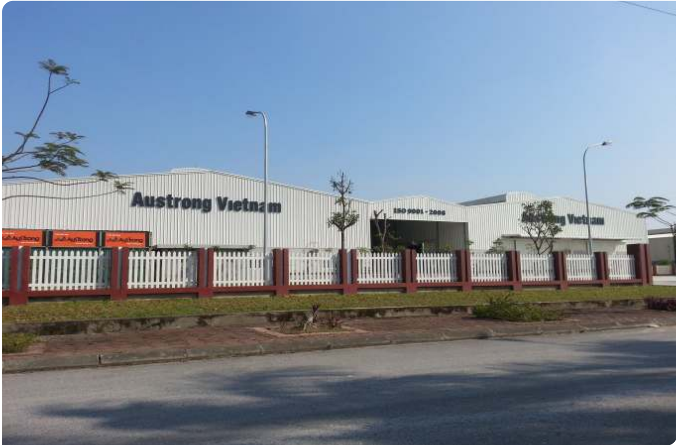
Nhà máy Austrong Bắc Ninh/ Diện tích: 12.000 m 2 KCN Thuận Thành 3, xã Thanh Khương, huyện Thuận Thành, tỉnh Bắc Ninh
